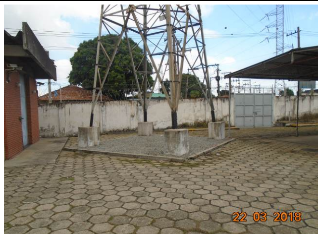
Foto 10: Vista da Torre de Transmissão de Energia que sai da ETD Miguel Paulista, na Rua Severina Leopoldina de Souza. Nota-se o local onde a torre está instalada.
