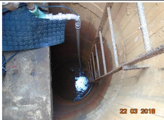
Foto 09: Dentro da ETD Miguel Paulista, há um sistema de bombeamento automatizado para controle da altura do lençol freático, que aflora no subterrâneo das instalações.
