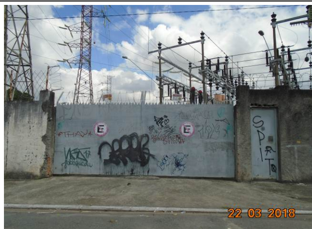
Foto 02: Vista dos fundos da ETD Miguel Paulista, localizada na Rua Idioma Esperanto, São Miguel Paulista – São Paulo, SP.
