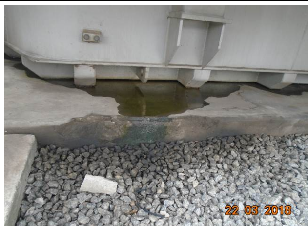
Foto 07: Detalhe da base do transformador que será substituído, onde há vazamento de um pequeno volume de óleo no interior da ETD Miguel Paulista.
