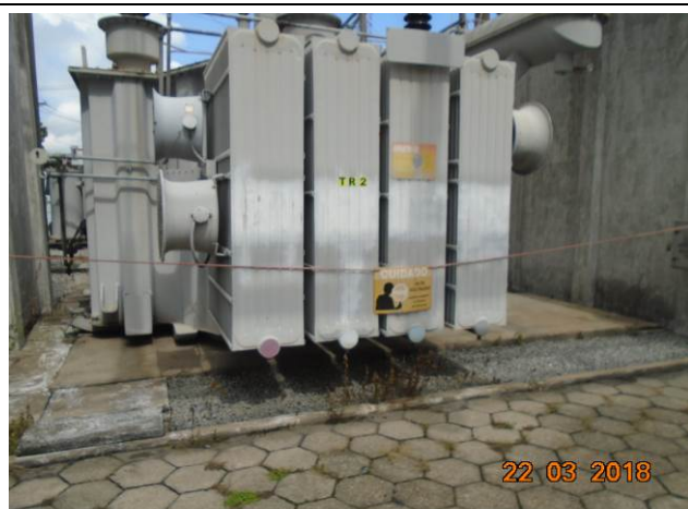
Foto 06: Detalhe da área onde será instalado o novo transformador no interior da ETD Miguel Paulista.
