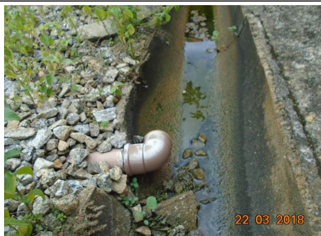
Foto 08: No interior da ETD Miguel Paulista há uma pequena ressurgência hídrica, que atesta a instalação da mesma próxima a calha do Rio Itaquera.
