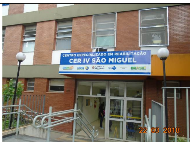
Foto 24: Na Rua Professor Antônio Gama de Cerqueira, localiza-se um Hospital Dia, com inúmeras alas e centros de especialização, como ilustra a foto.
